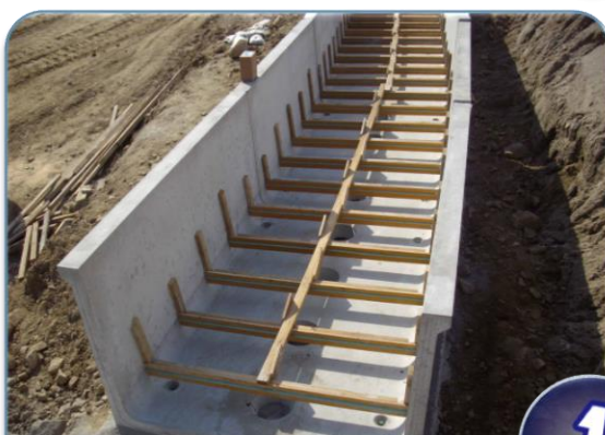
階段水路部（インパート打設前）
