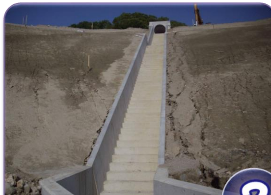
階段水路部（インパート打設後）
