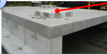
削孔訓練用スラブ
