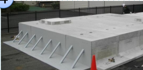
訓練施設組立完成
