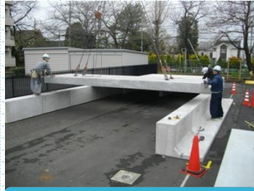
製品2上部スラブ設置
