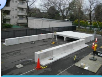
製品2下部ブロック設置
