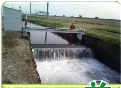
ゲート施工前
