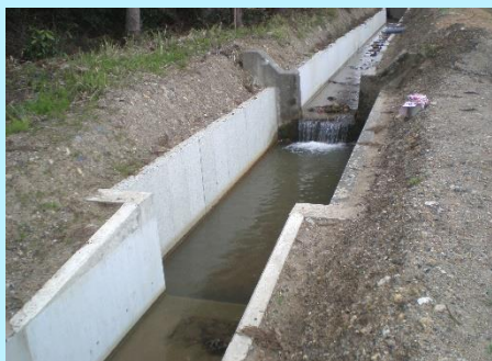
勝山北部地区 (施工直後)
