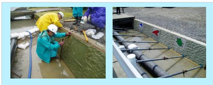
既設水路のパネル補強工法にダクトル化粧板を使用し、その上にダクトル絵パネルを設置した。
