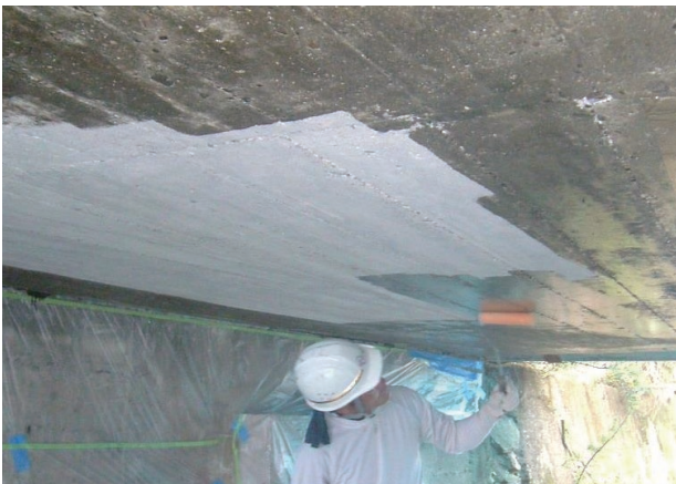
② プライマー塗布工
