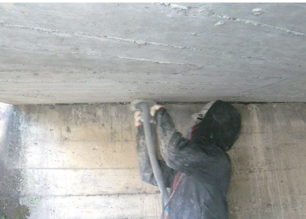
① 下地処理工（ケレン工）
