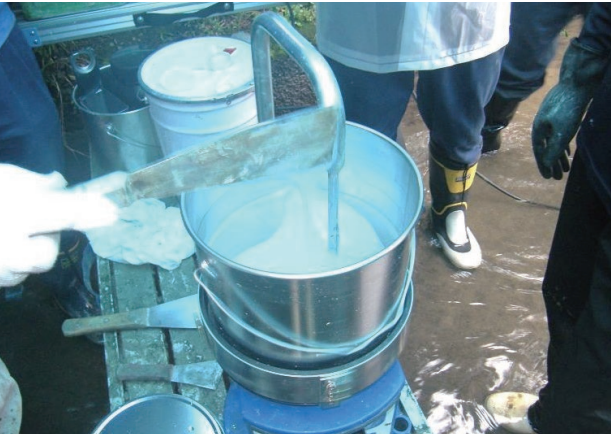
③ 材料攪拌状況
