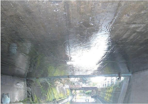
⑥ 施工完了
