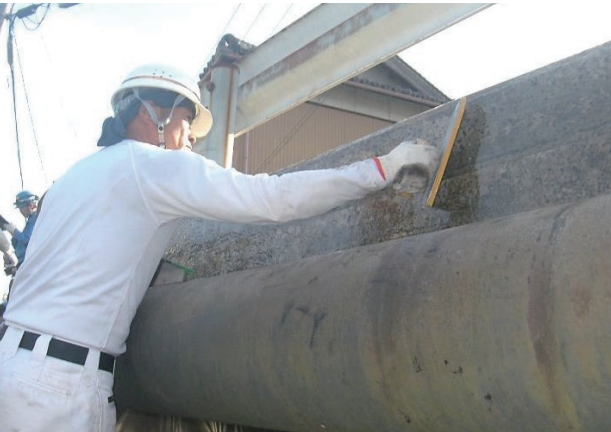
⑤ 表面被覆工（地覆）
