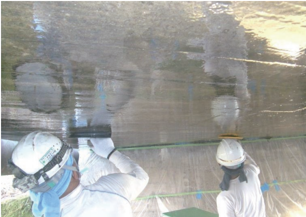
④ 表面被覆工（床版下面）
