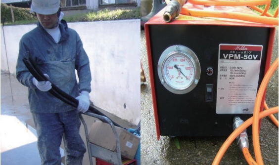
目地材吸引工（右：吸引ポンプ） （吸引ポンプによる目地材内空気の吸引）
