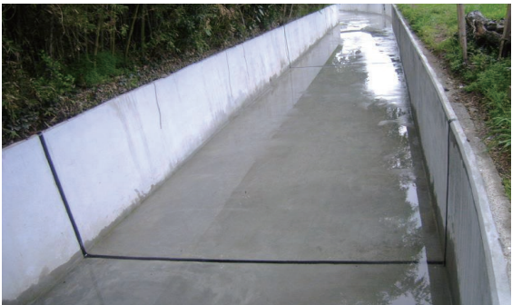
施工完了 （AS モルタル工法との併用）
