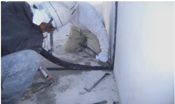
目地材挿入工 （直角部：90° について一本物施工可）
