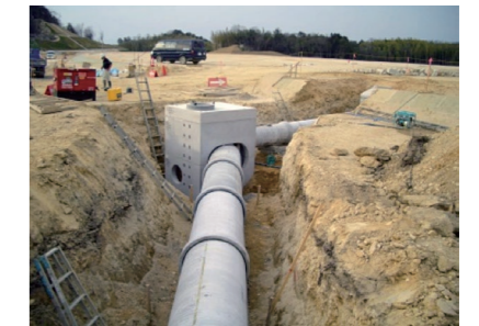
ヒューム管接続
