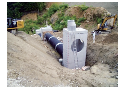
ハウエル管接続
