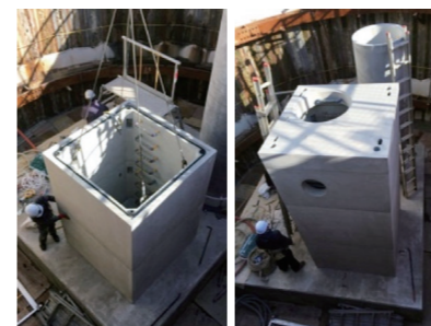
下部現場打の上部工
