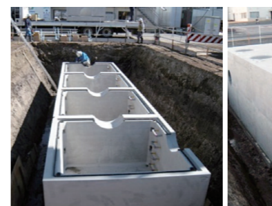
油水分離槽（4連）
