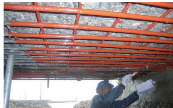
① 防錆材塗布工 (はつり後)
