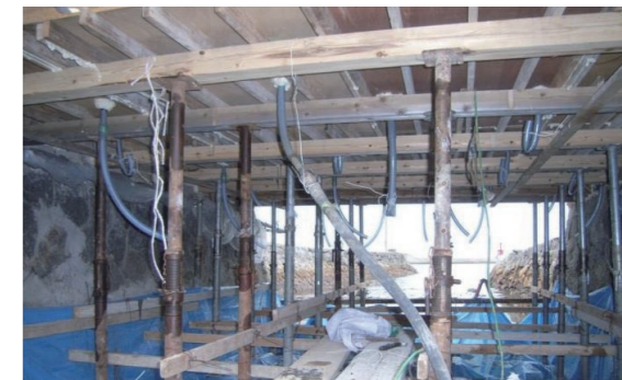
② 断面修復工 (型枠+ポリマーセメントグラウト充填)
