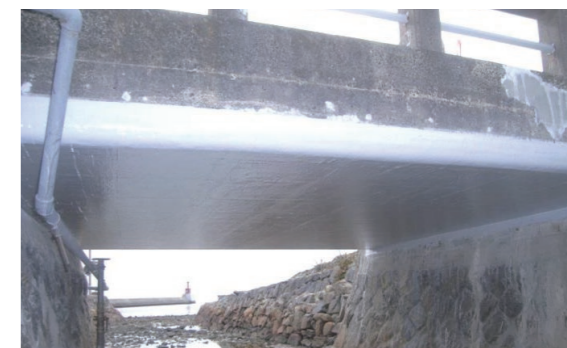
⑧ 施工完了
