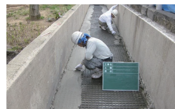
ポリマーセメントモルタル塗布工
