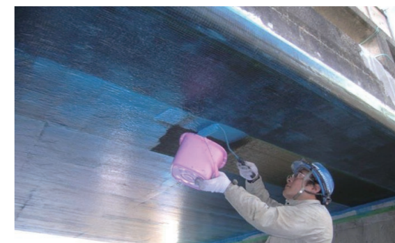
④ 不陸修正工 ⑤ 含浸樹脂塗布工
