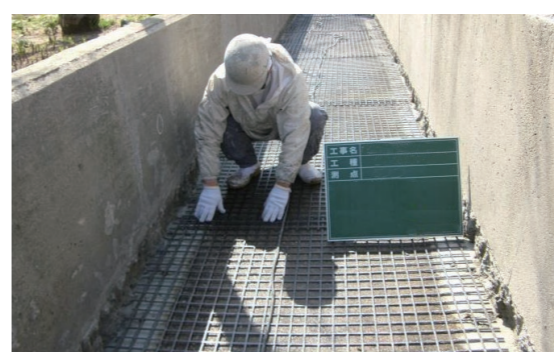
FRP格子筋設置工
