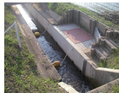
木製階段工をつけた例
