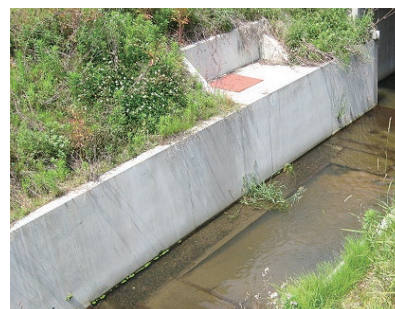
幹線排水路の設置例
