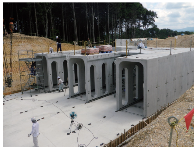
施工場所：愛知県内 内空高さ：H-3500 貯留容量：800m 3
