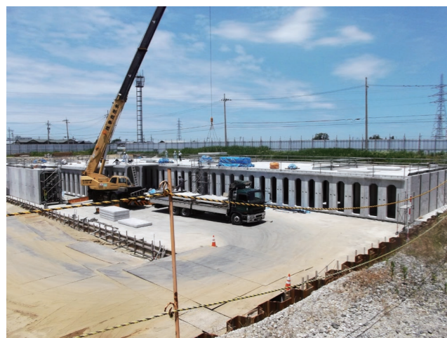
施工場所：福井県内 内空高さ：H-3500 貯留容量：5650m 3
