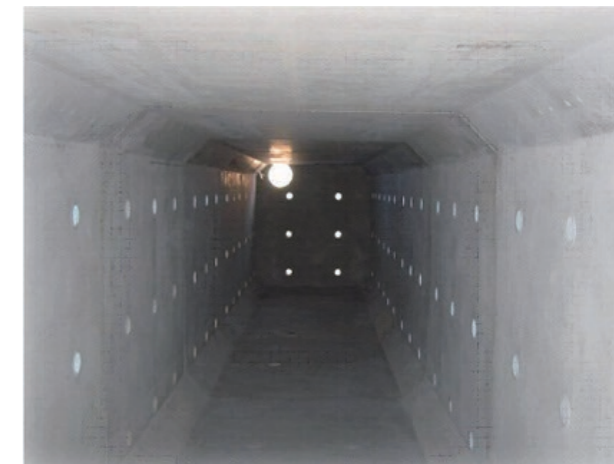
浸透機能を付加したボックス貯留槽の内部
