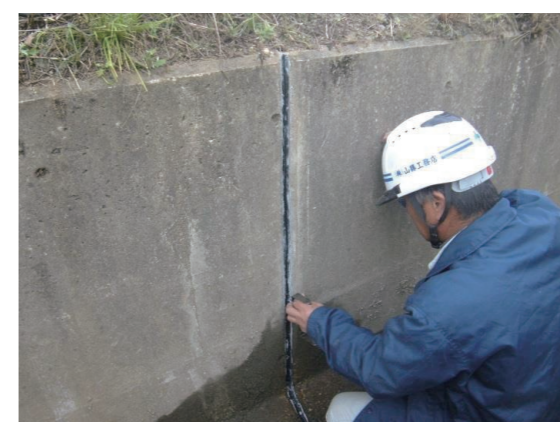
成型ゴム挿入工 (直角部：90°についても一物施工可)
