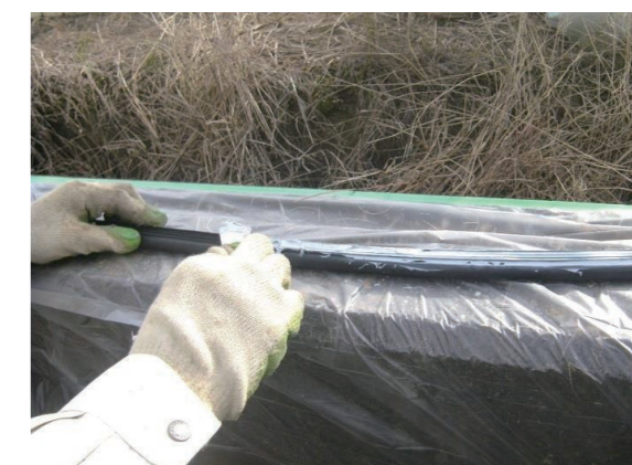
接着剤塗布工 (接着剤塗布状況)
