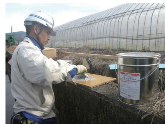
接着剤塗布工 (接着剤混練状況)
