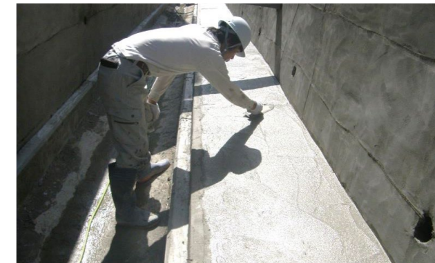
② 不陸調整工
