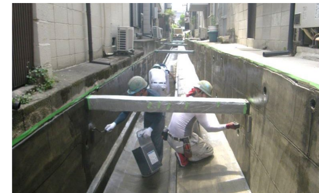
④ プライマー塗布工
