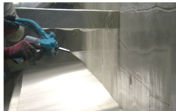
⑤ ポリウレタン樹脂吹付工
