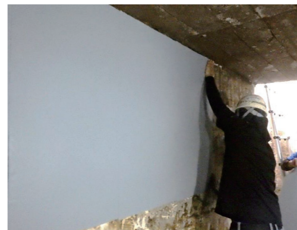
シート貼付工
