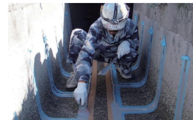
④ シーリング材充填工
