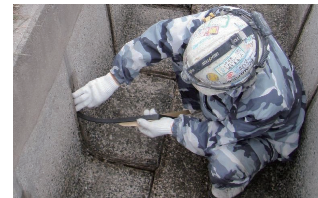
② バックアップ材装填工
