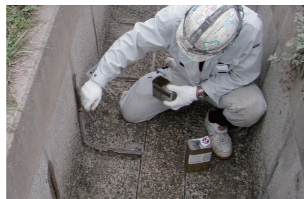
③ プライマー塗布工
