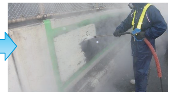
施工状況（加圧高温水洗浄状況）
