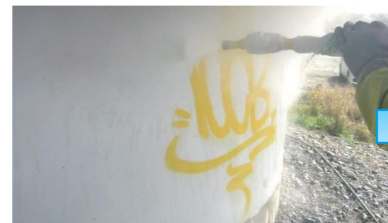
落書き除去（橋脚）施工前
