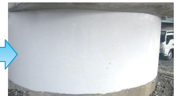
落書き除去（橋脚）施工完了
