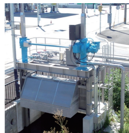
ポンプ搭載型 (滋賀県)
