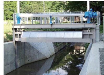
ゲートを上げ砂礫を排出
