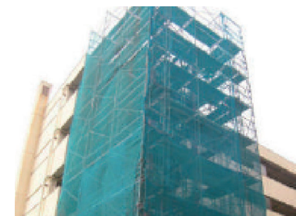
従来工法の足場仮囲い
