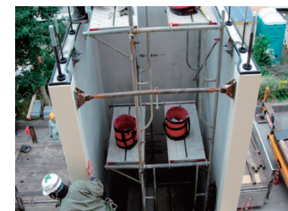
ラクシスの組立は内足場のみ
