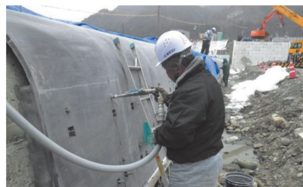
⑤ 無収縮グラウト充填工
