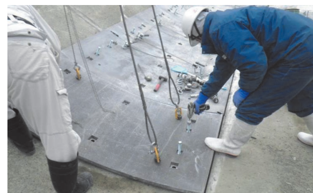
② パネル設置工（高さ調整）
