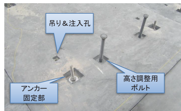
④ パネル設置工（パネル固定）
