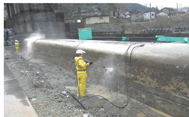
① 下地処理工（高圧洗浄）
