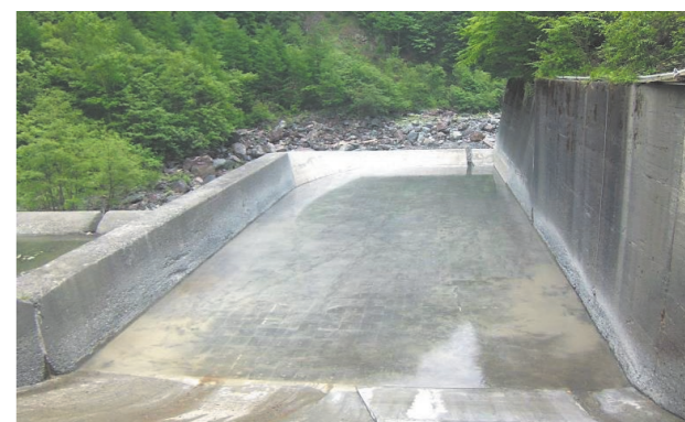
ダム：土砂吐け部
