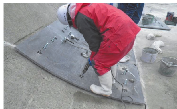
③ アンカー工
