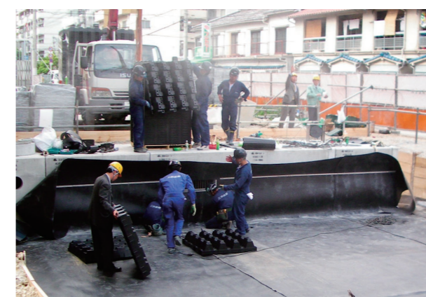
貯留容量: 2578m³ (1次貯留槽: 154m³、2次貯留槽: 2424m³)
