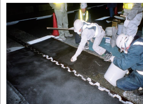
MMA樹脂モルタル打設
