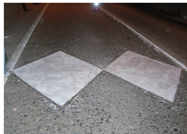
施工完了 (薄層補修工法)
