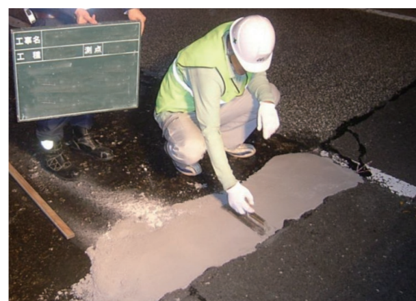
MMA樹脂モルタル打設
