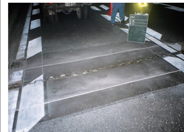
施工完了 (橋梁伸縮装置嵩上げ工法)
