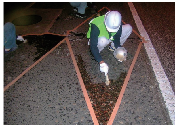
プライマー塗布工
