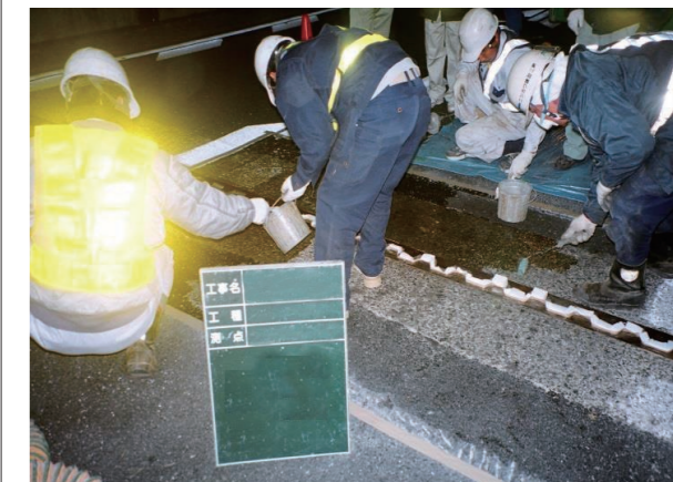
プライマー塗布工
