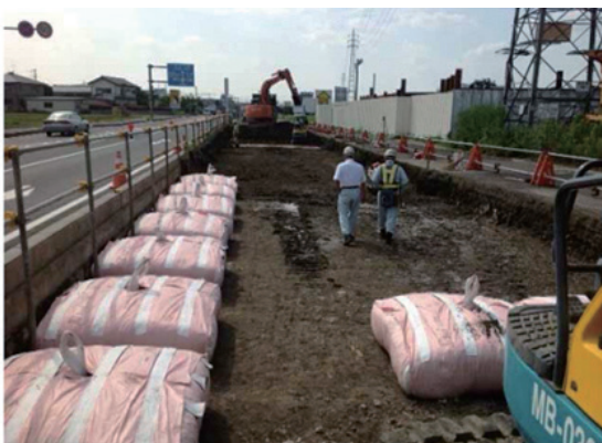
道路地盤補強工事
