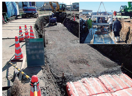
ボックスカルバート下部地盤補強工事
