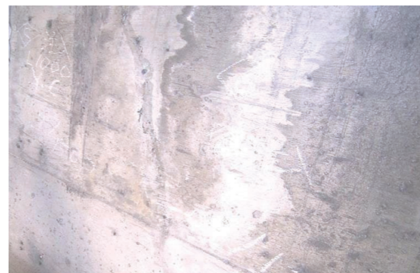
⑤施工完了
