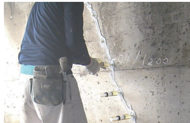
③エポキシ樹脂注入工
