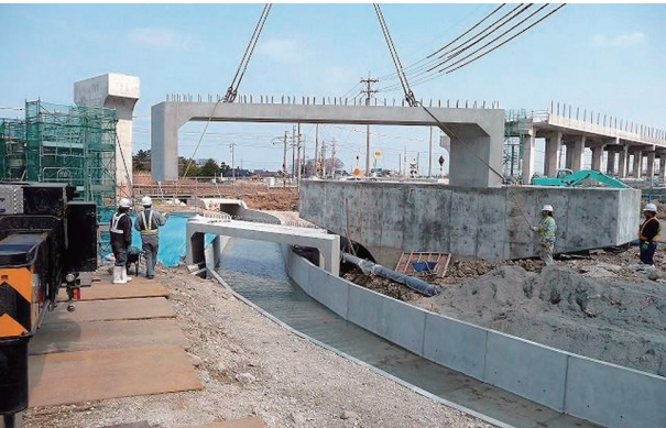
斜角門形カルバート（水替え工なし）
