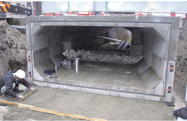
斜角2分割ボックスカルバート（水路改修）
