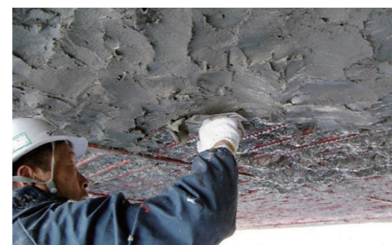
③ 断面修復（ASモルタルT）
