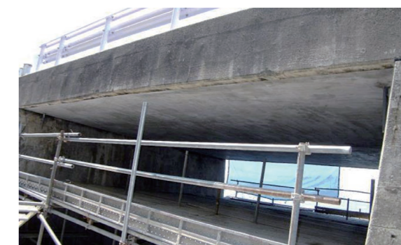
④ 施工完了
