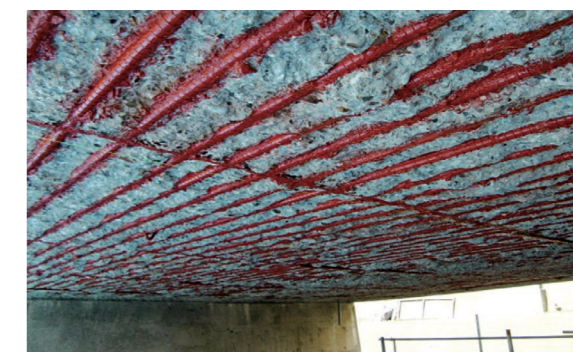
② 防錆材塗布
