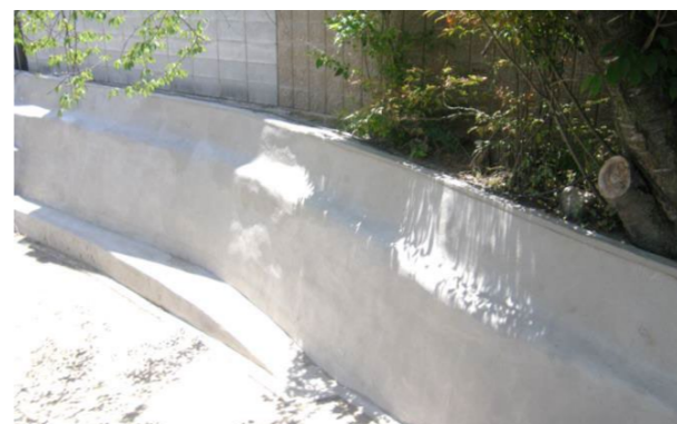
⑤ 施工完了
