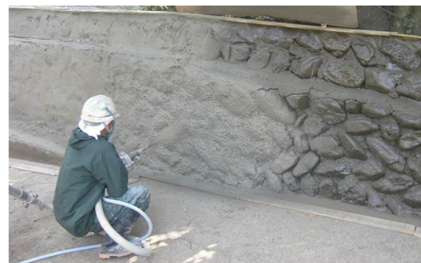
③ 吹付施工
