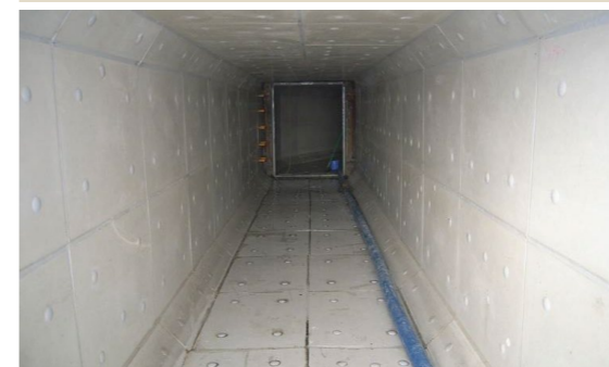
下水処理施設補修
