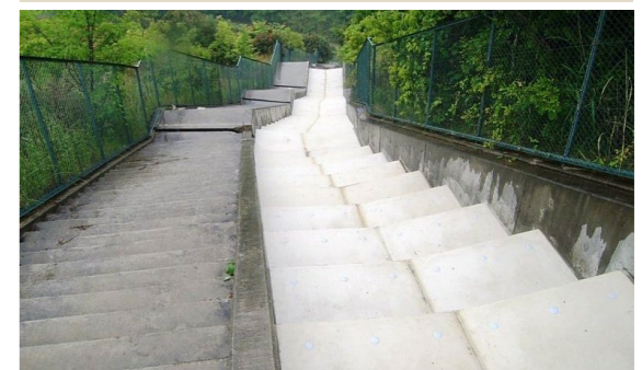
水路落差部補修
