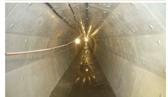
導水路トンネル補強
