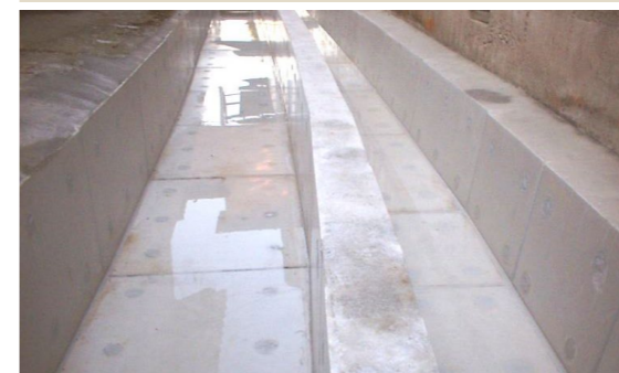
農業水利施設補修
