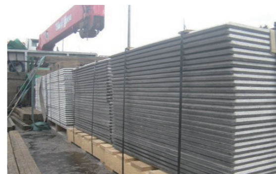
材料搬入(緩衝材付きパネル)
