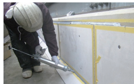
パネル目地工(弾性シーリング材充填状況)
