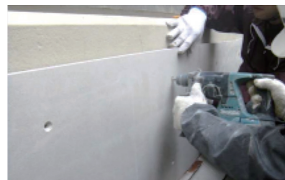
アンカー工(削孔状況)
