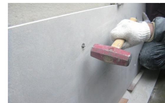
アンカー工(打設状況)
