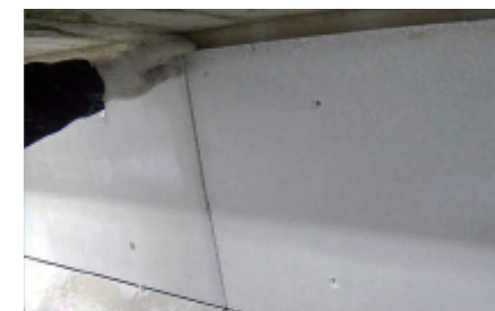
パネル設置工
