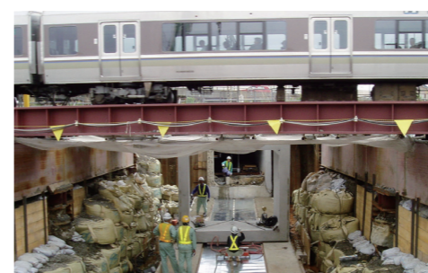
鉄道高架下人道ボックス工事
