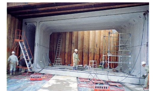
河川改修工事
