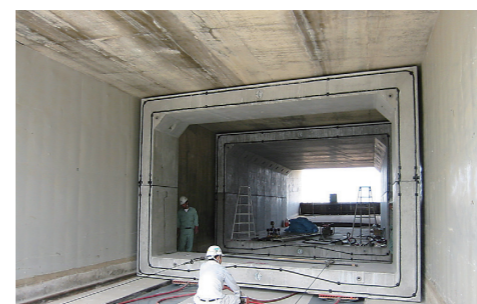
函渠補修工事
