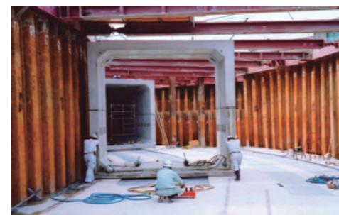
河川改修工事
