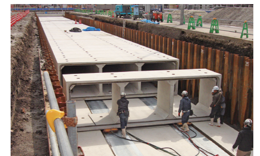
雨水貯留槽工事
