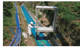
キャスター板上に函体吊降ろし
