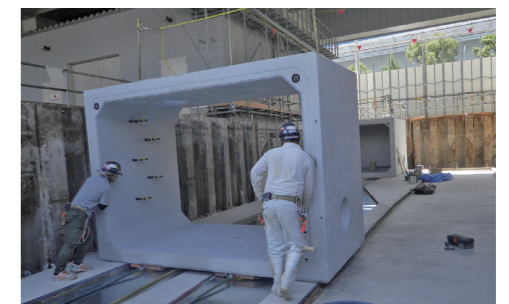
鉄道高架下雨水貯留槽工事
