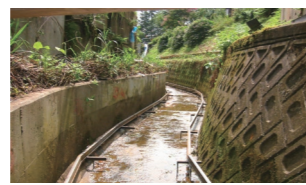
基礎鋼材設置
