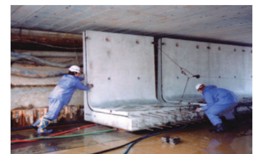
雨水幹線整備工事
