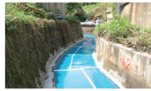
滑走面養生鉄板設置
