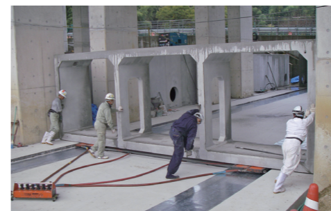
高速道路高架下工事
