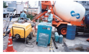
底版モルタル圧送
