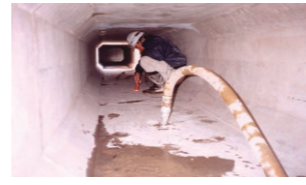
モルタル注入
