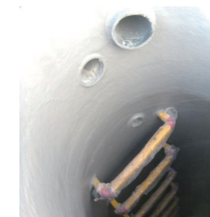
工場排水処理施設（薬液槽等） （エポマー GP-303/VE-200）
