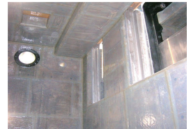
シートライニング工法 規格：D種適合工法 （サンシートS600工法）
