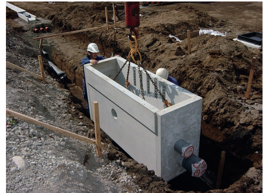
通信接続樹設置
