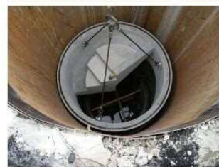
③ 部材据付工-落差部・調整側壁部
