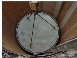
② 部材据付工-底版
