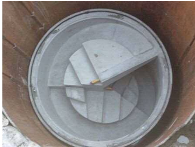
落差マンホール内部構造
