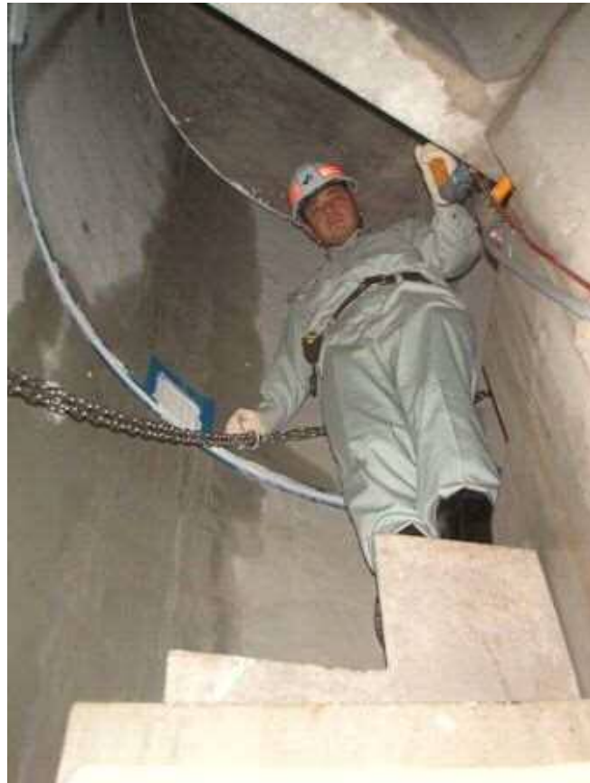
入孔状況①
