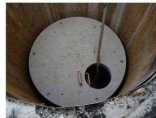
④ 部材据付工-蓋版
