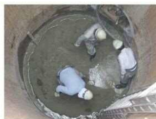
① 仮設工、敷モルタル工
