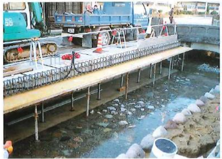
写真: 金沢市鞍月用水整備工事 施工延長220m
