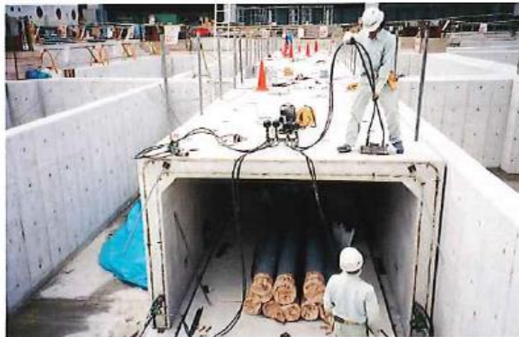
写真: 大阪市中心卸売市場共同溝 施工規模 120ブロック
