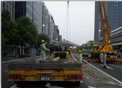
クレーンにて、据付を行います。
