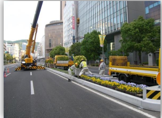
据付完了です。内部に植栽を施します。
