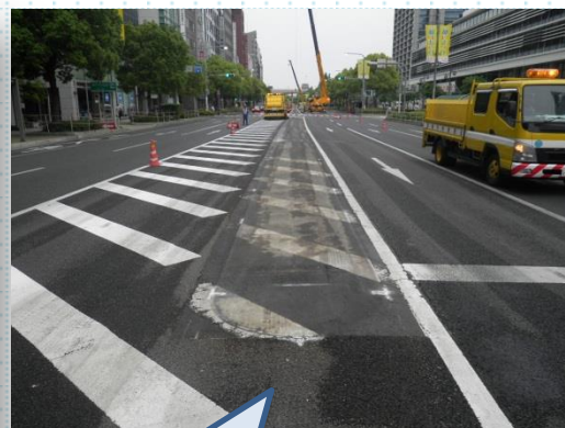
中央分離帯撤去
