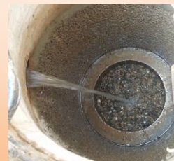
設置後2年経過した浸透施設
