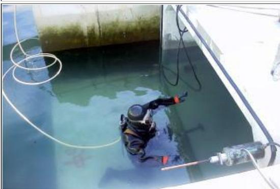
潜水夫によるPC鋼材を用いたBOX部材緊張
