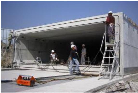
縦方向連結(PC鋼材による緊張)
