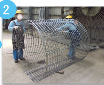
鉄筋カゴ組立
