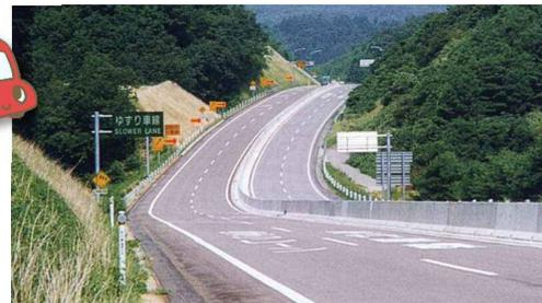
「PGF」は自動車の車線外への突っ込み事故を防ぐプレキャストコンクリート製の剛性防護柵です!
